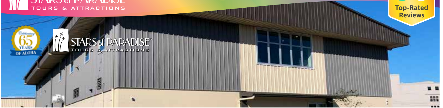
ベストバリューを目指し、オフィス、キッチン、バス整備工場を備えた、100%ソーラーエネルギーの総合自社ビル
